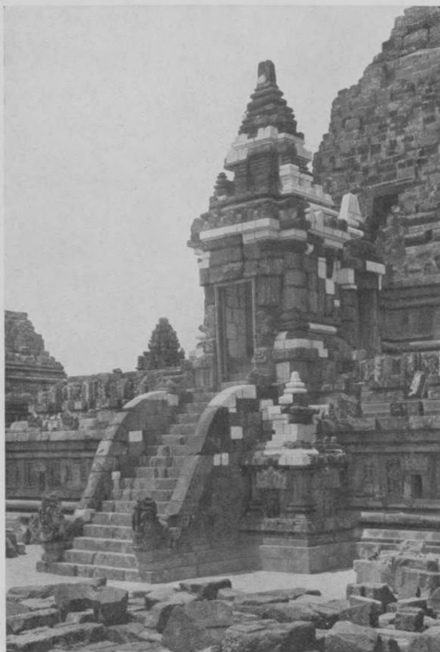
Voorlaatste stadium eener reconstructie: de proefopstelling. Nadat de ontgraven steenen en fragmenten zijn gesorteerd en aaneengepast en de reconstructie op papier haar beslag heeft gekregen, wordt het te reconstrueeren bouwdeel met behulp van blokken uit tijdelijk materiaal — die later vervangen worden door nieuwe steenen — in een proefopstelling op het terrein opgezet. De afbeelding toont de proefopstelling van een der poorten van den hoofdtempel te Prambanan (aanvang 10e eeuw A.D.) De lichtgekleurde steenen zijn de tijdelijke.
